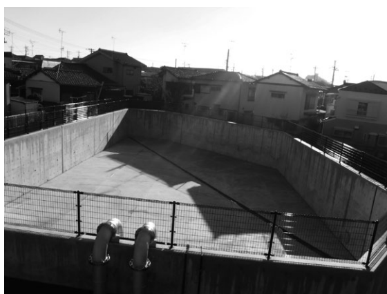
南初富2丁目雨水貯留池
