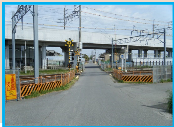
切替前の北初富3号踏切
