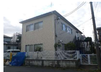
建築 外壁（北面・東面）
