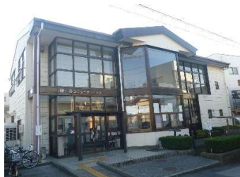
建築 外壁（北面）
