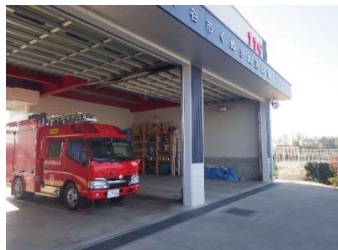
建築 内部（車庫）
