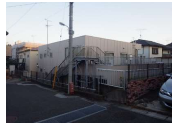
建築 外壁（北面・西面）
