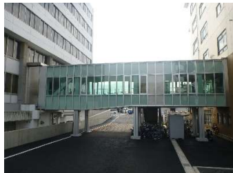
建築 外壁（北面）
