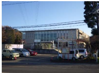
建築 外壁（北面・西面）
