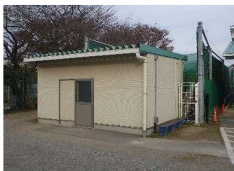
建築 外壁（西面）アーチェリー場
