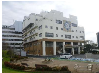
建築 外壁（北面・西面）
