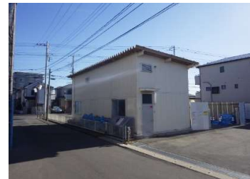
建築 外壁（南面・西面）
