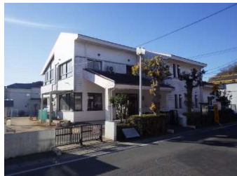
建築 外壁（北面・東面）
