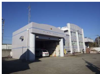
建築 外壁（東面）
