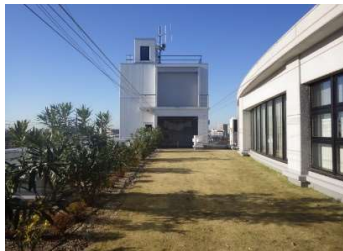
建築 屋上防水
