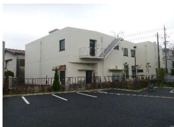
建築 外壁（北面・東面）
