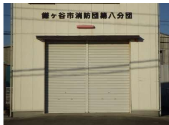
建築 外壁（車庫シャッター）
