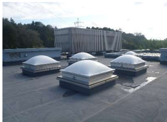
建築 屋上防水
