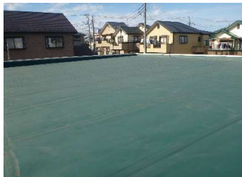
建築 屋上防水
