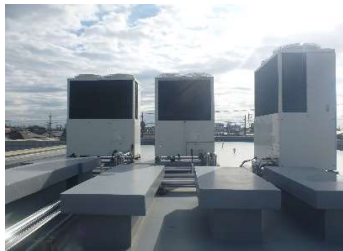
建築 屋上防水
