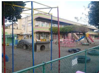
建築 外壁（南面・西面）
