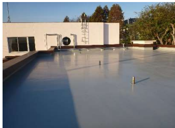
建築 屋上防水
