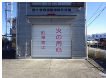
建築 外壁（車庫シャッター）
