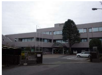
建築 外壁（西面）
