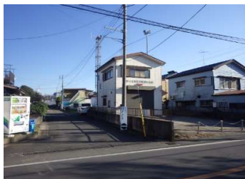
建築 外壁（西面）
