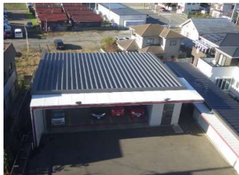
建築 屋上防水
