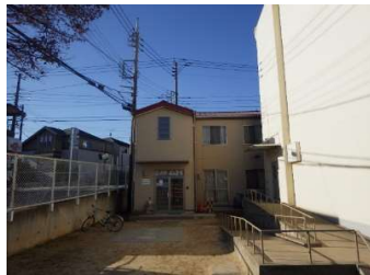
建築 外壁（東面）
