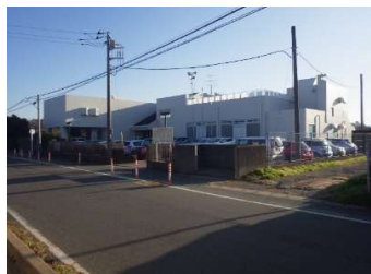
建築 外壁（北面・西面）
