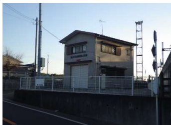
建築 外壁（北面）
