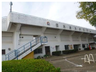
建築 外壁（東面）
