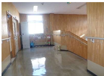
建築 内部（2階共用部）
