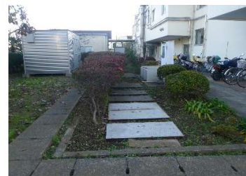
機械 給排水設備（浄化槽）
