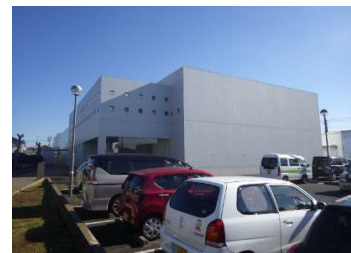
建築 外壁（北面・西面）
