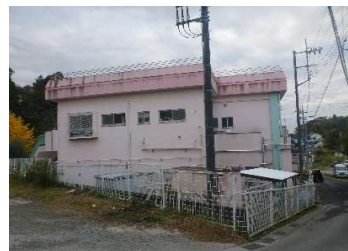
建築 外壁（東面）
