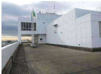
建築 屋上防水
