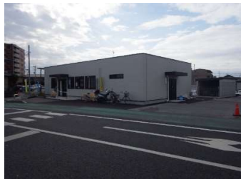
建築 外壁（北面・東面）
