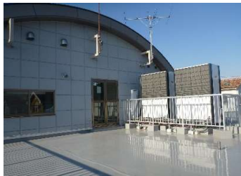
建築 屋上防水
