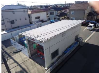
建築 屋上防水
