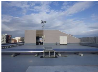
建築 屋上防水
