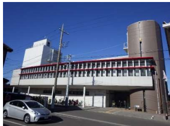
建築 外壁（東面）
