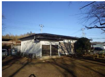
建築 外壁（南面・西面）
