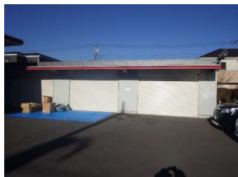
建築 外壁（東面）
