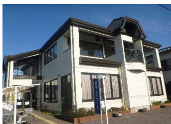
建築 外壁（南面・西面）
