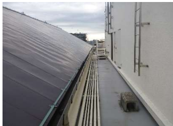
建築 屋上防水
