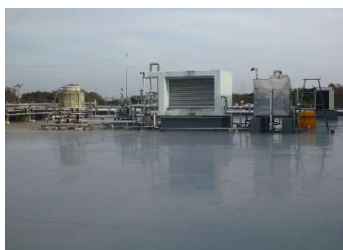
建築 屋上防水
