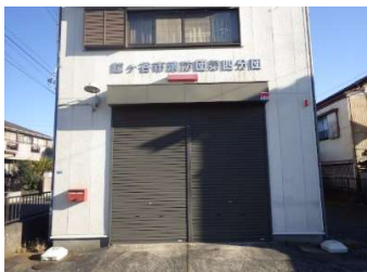
建築 外壁（車庫シャッター）
