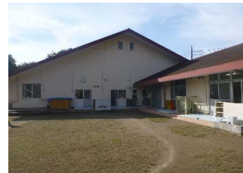
建築 外壁（北面・東面）
