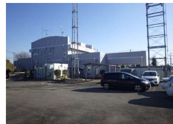
建築 外壁（西面）
