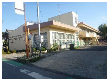
建築 外壁（南面・西面）
