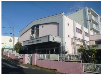
建築 外壁（南面・西面）
