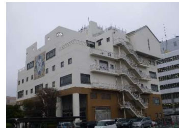
建築 外壁（南面・西面）
