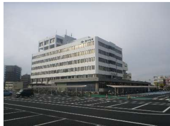
建築 外壁（北面・東面）
