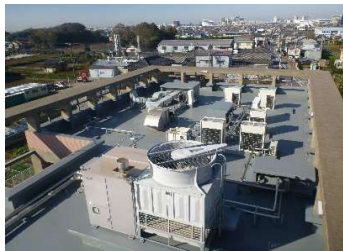
建築 屋上防水
