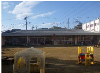
建築 屋上防水
