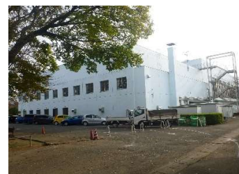
建築 外壁（北面・西面）
