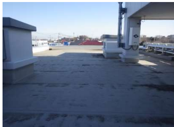
建築 屋上防水
