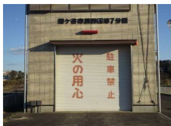
建築 外壁（車庫シャッター）
