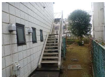
建築 外部（鉄骨階段）
