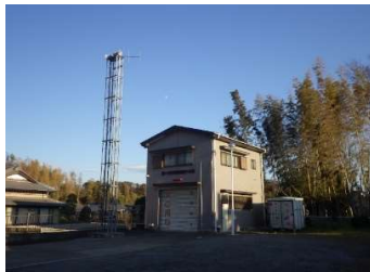
建築 外壁（北面）
