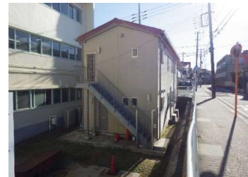
建築 外壁（北面・西面）
