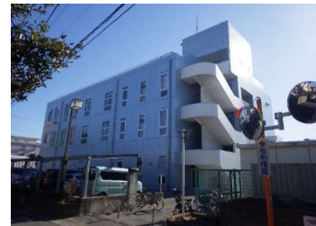
建築 外壁（北面・西面）
