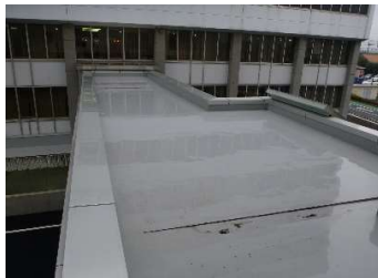
建築 屋上防水
