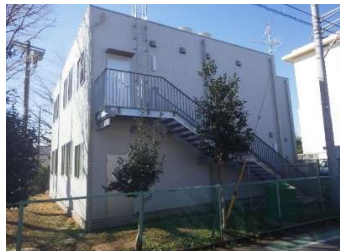
建築 外壁（北面・東面）
