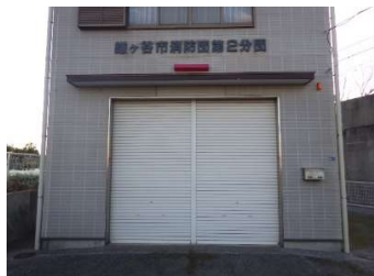
建築 外壁（車庫シャッター）
