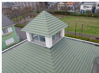
建築 屋根（遊戯室）
