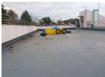
建築 屋上防水
