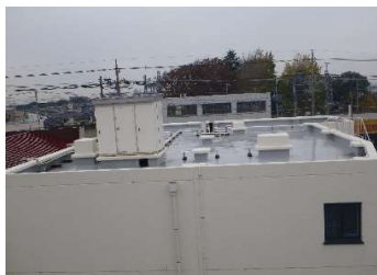
建築 屋上防水
