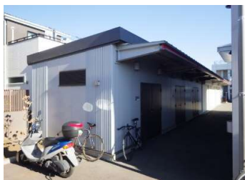
建築 外部（南面・東面）
