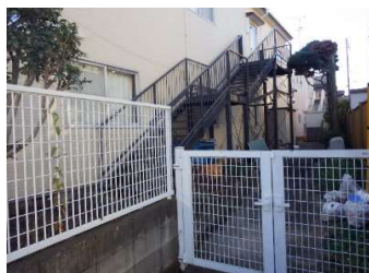
建築 外部（鉄骨階段）
