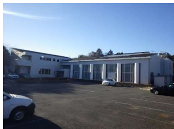
建築 外壁（北面・西面）
