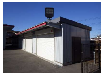
建築 外壁（北面・東面）
