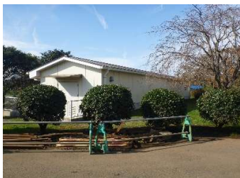
建築 外壁（北面・東面）
