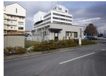
建築 外壁（南面・西面）
