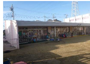
建築 外壁（東面）
