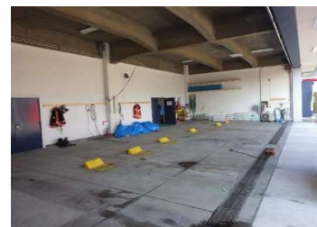
建築 内部（車庫）
