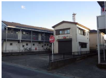
建築 外壁（北面）
