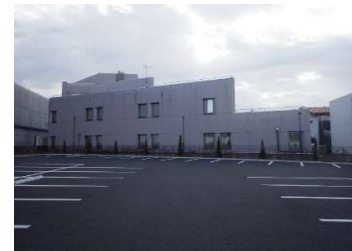
建築 外壁（北面）
