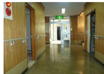
建築 内部（1階共用部）
