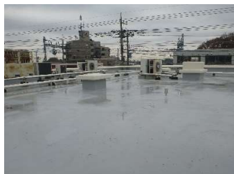
建築 屋上防水
