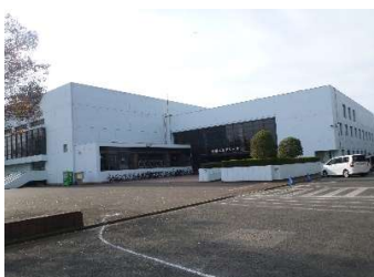
建築 外壁（北面・東面）
