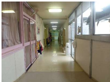
建築 内部（1階共用部）
