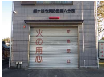
建築 外壁（車庫シャッター）
