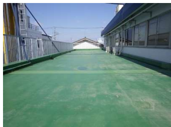
建築 屋上防水（2階）
