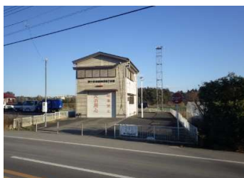
建築 外壁（西面）
