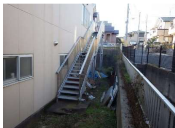
建築 外部（鉄骨階段）
