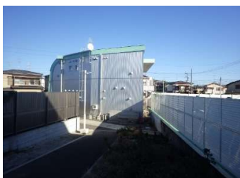
建築 外壁（西面）
