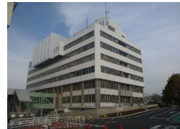
建築 外壁（南面・西面）
