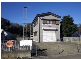
建築 外壁（東面）
