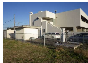
機械 給排水設備（浄化槽）
