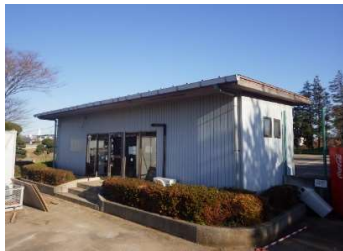
建築 外壁（南面・西面）
