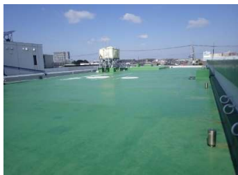
建築 屋上防水（1階）
