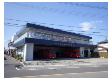
建築 外壁（北面・東面）
