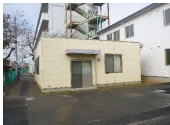
建築 外壁（東面）
