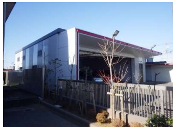
建築 外壁（北面）
