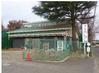
建築 外壁（西面）弓道場
