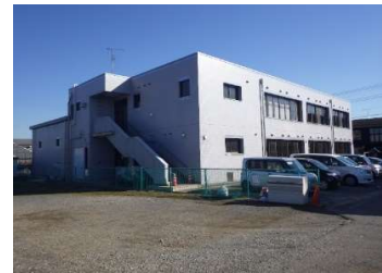
建築 外壁（南面・西面）
