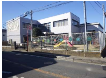
建築 外壁（北面・東面）
