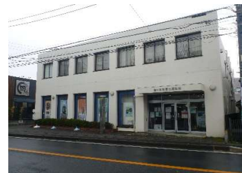
建築 外壁（西面）
