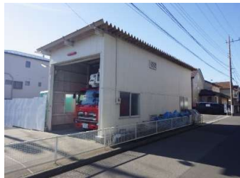
建築 外壁（北面・西面）
