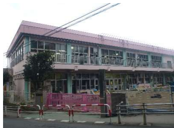
建築 外壁（南面・西面）
