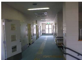
建築 内部（2階共用部）
