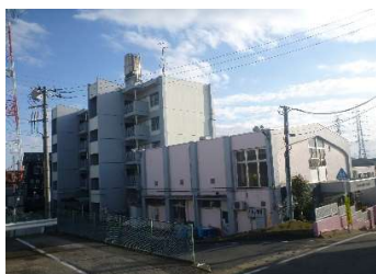
建築 外壁（北面・西面）
