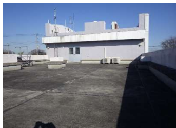
建築 屋上防水
