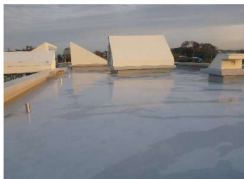
建築 屋上防水
