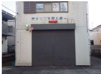
建築 外壁（車庫シャッター）
