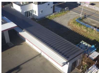
建築 屋上防水
