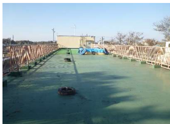
建築 屋上防水
