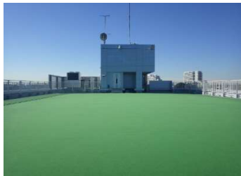
建築 屋上防水
