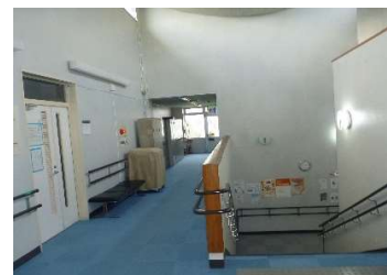
建築 内部（2階共用部）
