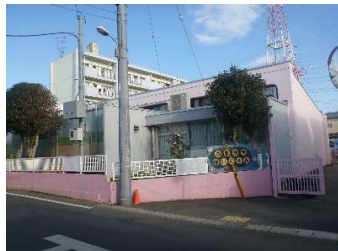
建築 外壁（西面）
