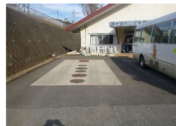
機械 給排水設備（浄化槽）
