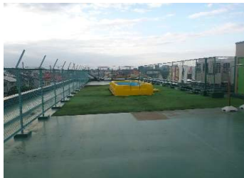
建築 屋上防水
