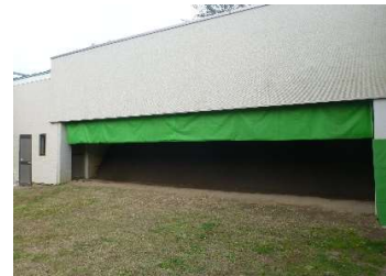
建築 外壁（西面）弓道場の場
