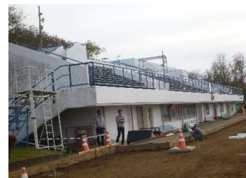
建築 外壁（西面）
