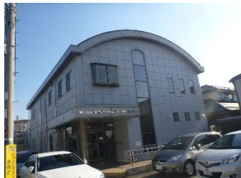
建築 外壁（北面・西面）
