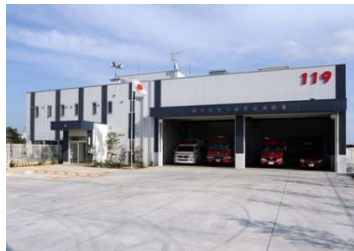
建築 外壁（北面）
