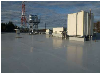
建築 屋上防水
