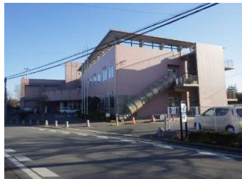
建築 外壁（北面・西面）
