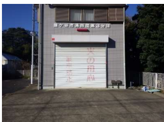
建築 外壁（車庫シャッター）
