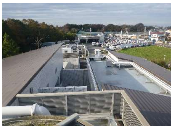
建築 屋上防水
