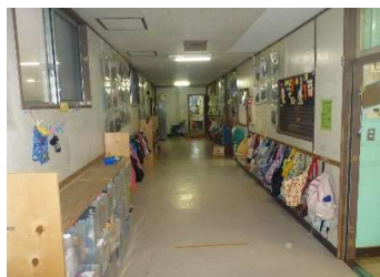
建築 内部（1階共用部）
