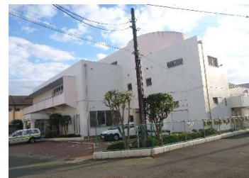
建築 外壁（北面・西面）
