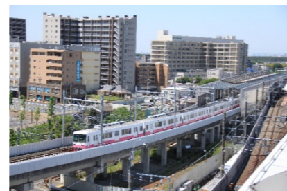
新京成線連続立体交差事業
