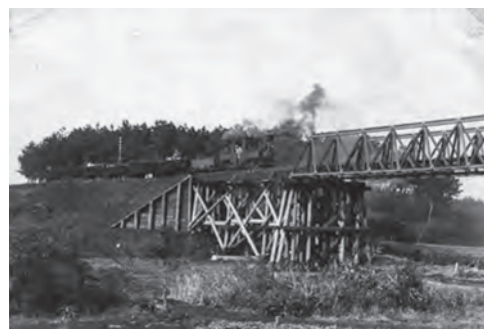
鉄道第二連隊(聯隊)架橋鎌ヶ谷橋脚(昭和6年頃)
